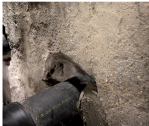
Abdeckung mit Mapegrout T40
