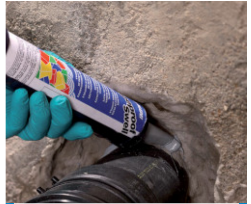
Applikation von Mapeproof Swell ums Rohr
