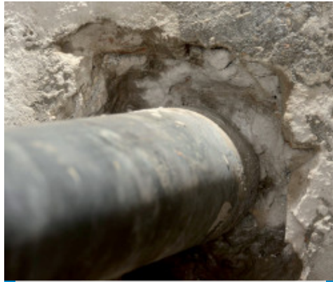
Abtragen des Betons rund um die Leitung
